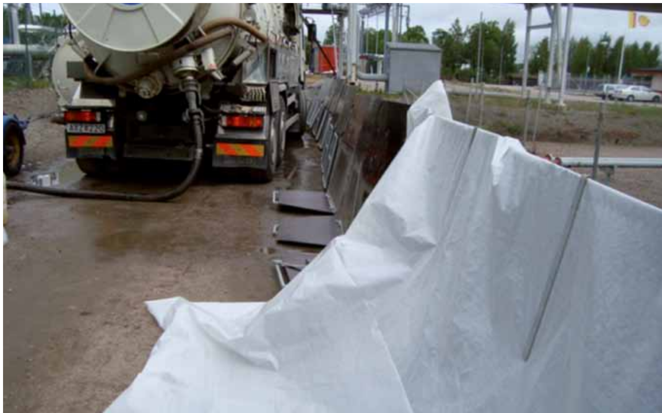
Bild 7.3. Vädduk över pallbarriär behövs för tätningsändamål
