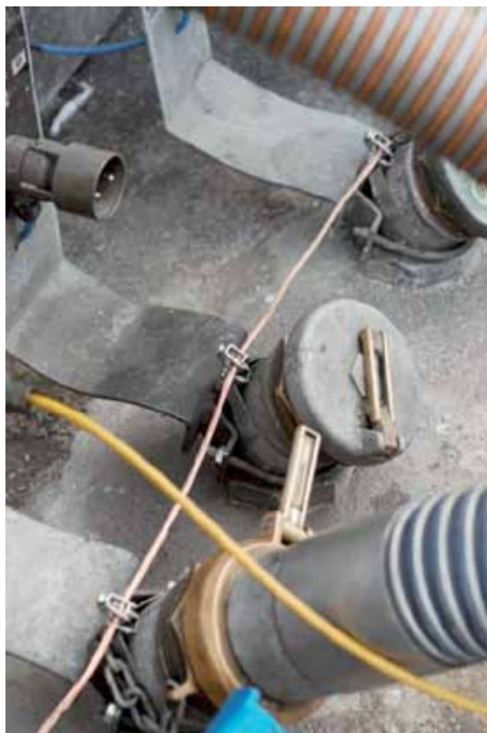
Bild 8 Gul kabel är tankfordonets anslutning av överfyllningsskydd.
