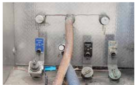
Bild 9 Förbindning avluftningsrör.
