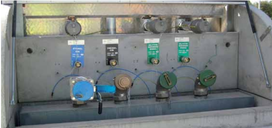
BILD 5: MÄRKNING PÅ CENTRALPÅFYLLNING (CPF)
